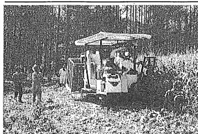
実際の作業を見て導入に向けて細かい質問が多数出た
