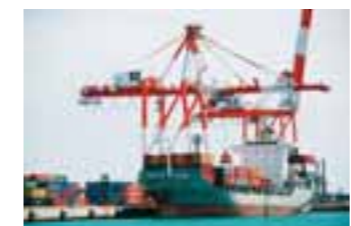
Tomakomai East Port (International Container Terminal) 苫小牧東港（国際コンテナターミナル）
