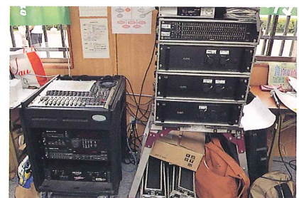
本部内放送設備
