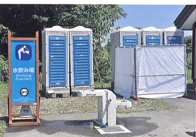
仮設トイレ(北側)
