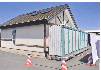
仮設トイレ(本部横)
